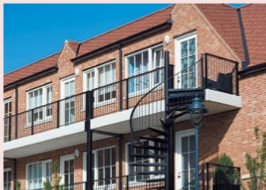
CIRCULAIR, DUURZAAM EN BETAALBAAR WONEN Tudorstijl appartementencomplex; de nieuwe generatie is geschikt gemaakt voor hergebruik door toepassing van stalen modules die demontabel zijn.
