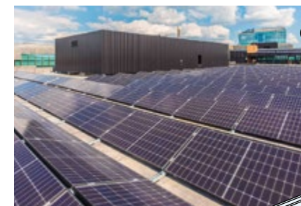
8 Optimaal gebruik zonne-energie. 875 zonnepanelen met een vermogen van 315 kWh. Geschatte jaaropbrengst is 300 mWh/jaar.
